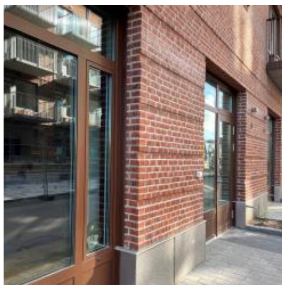
Referensbild på hur en markerad entré kan utformas.
