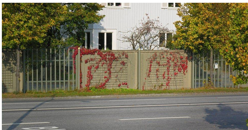
Figur 22. Bullerskärm utmed Drottningholmsvägen i Bromma. Källa: Svenskt trä.
