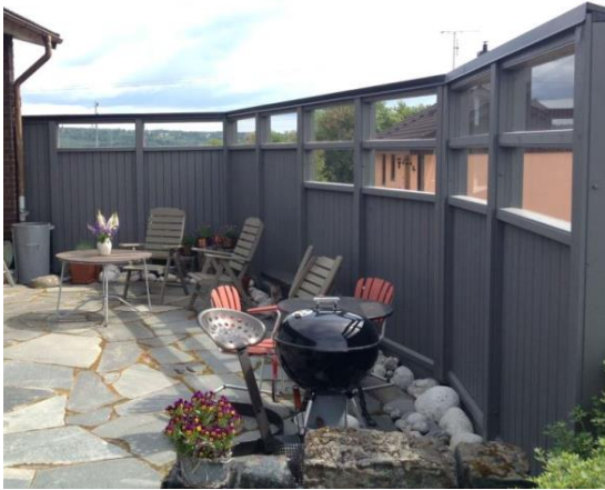
Figur 23. Lokal bullerskärm vid uteplats. Källa: Trafikverket.
