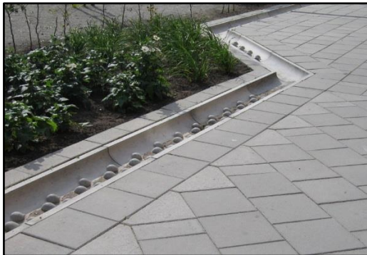
Figur 5-16 Öppen dagvattenränna (St. Eriks, 2016)
