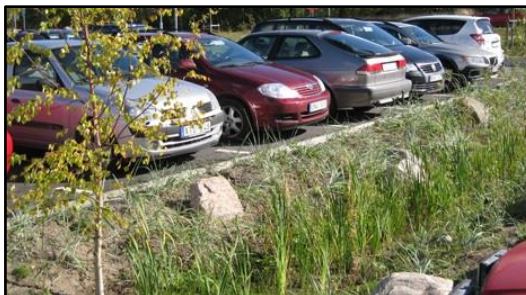
Figur 5-8 Avvattningsstråk med växter vid parkering
