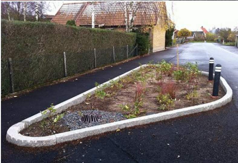
Figur 5-20, 5-21 Principlösning regnbädd/planteringsytor för avvattning från tak och lokalgator (Rent dagvatten och SLU).
