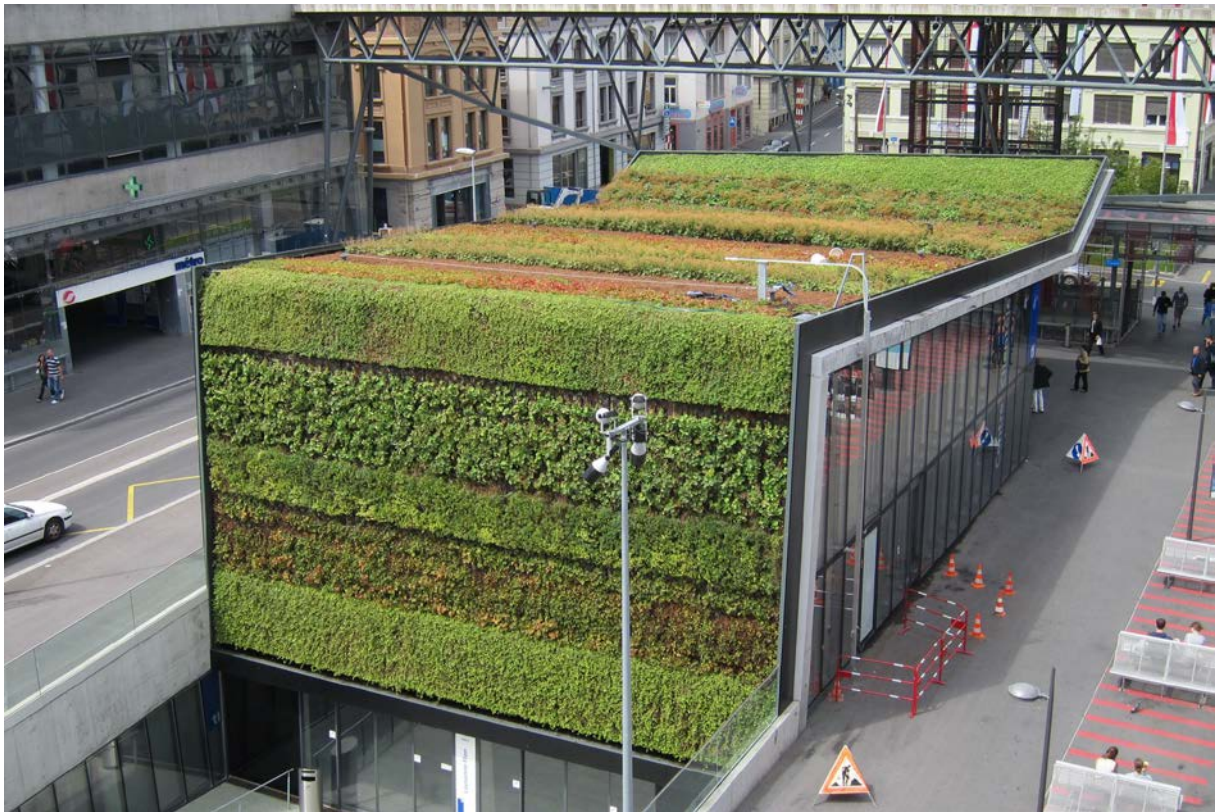
Figur 9. Grön vägg och grönt tak på en byggnad i Lausanne, Schweiz, installerat av företaget Canevaflor. Bild från www.rts.ch 8 .
